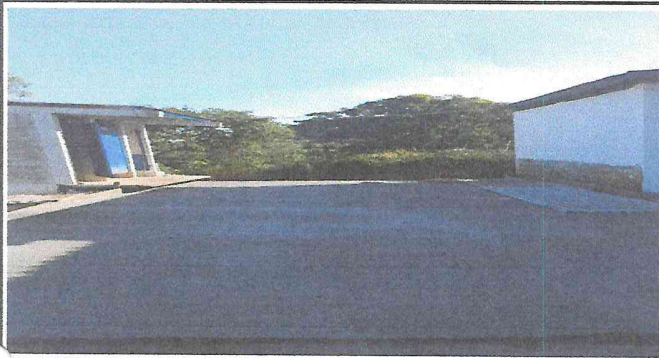
Foto 1: Área de los sanitarios en proceso
