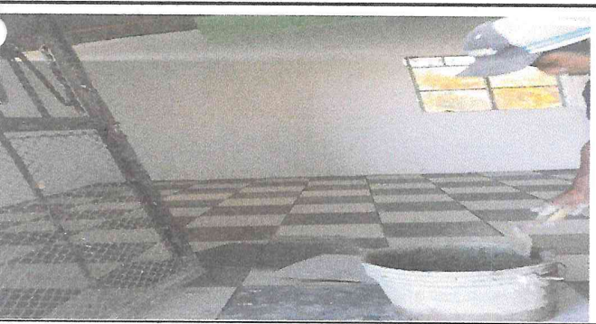
Foto 5: Cambio de piso de torta por piso cerámico
