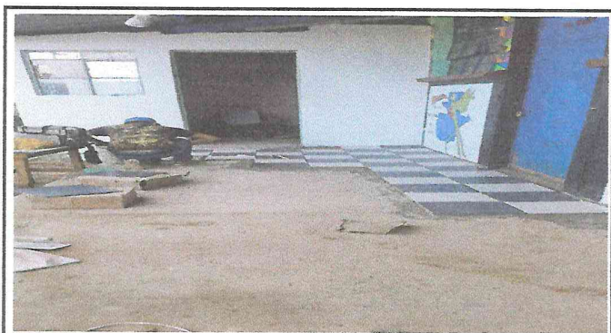
Foto 4: Cambio de piso cerámico en el corredor
